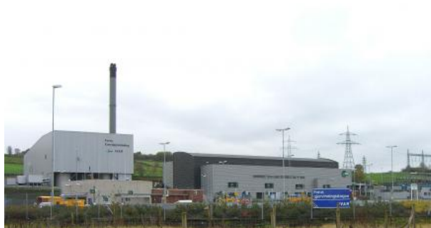
Figur 14: Forbrenningsanlegget til Forus Energigjenvinning
