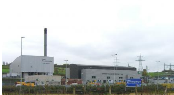
Figur 14: Forbrenningsanlegget til Forus Energigjenvinning
