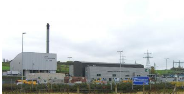
Figur 12: Forbrenningsanlegget til Forus Energigjenvinning
