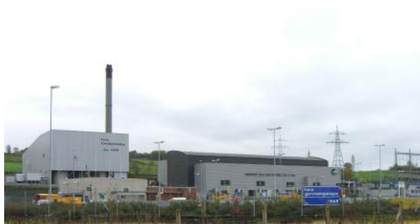
Figur 13: Forbrenningsanlegget til Forus Energigjenvinning
