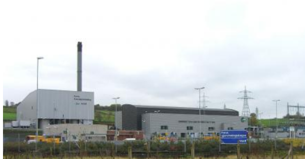
Figur 15: Forbrenningsanlegget til Forus Energigjenvinning
