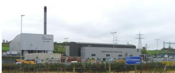
Figur 14: Forbrenningsanlegget til Forus Energigjenvinning
