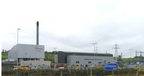
Figur 14: Forbrenningsanlegget til Forus Energigjenvinning
