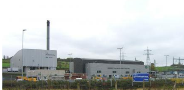
Figur 14: Forbrenningsanlegget til Forus Energigjenvinning
