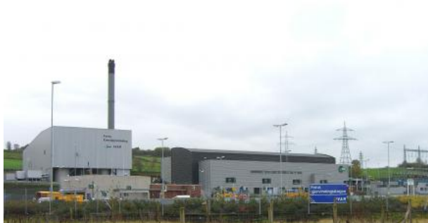
Figur 14: Forbrenningsanlegget til Forus Energigjenvinning
