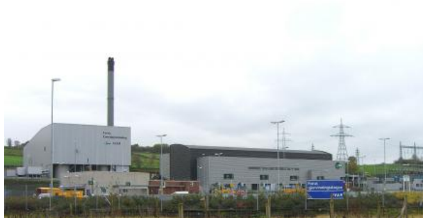
Figur 13: Forbrenningsanlegget til Forus Energigjenvinning
