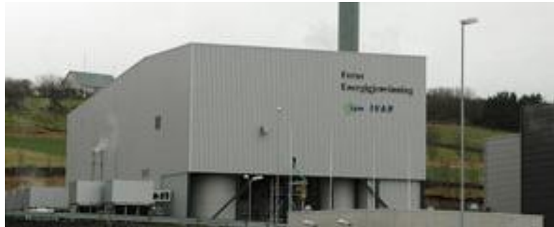
Figur 1: Forbrenningsanlegget til Forus Energigjenvinning
