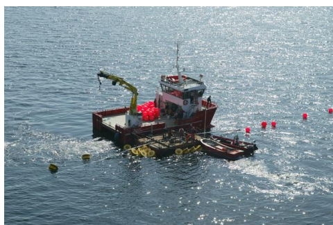
Figur 5: Legging av gassrør til Finnøy
